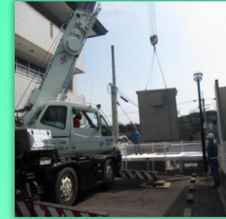
施工中 変電塔設置
