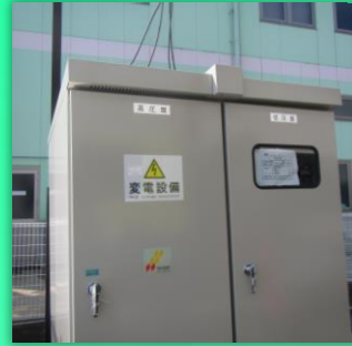
施工中 変電塔設置
