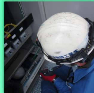
施工中 ケーブル配線
