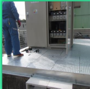
施工中 変電塔設置
