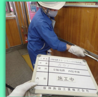
手すり 施工中
