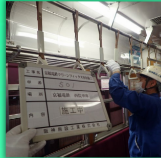
つり革 施工中
