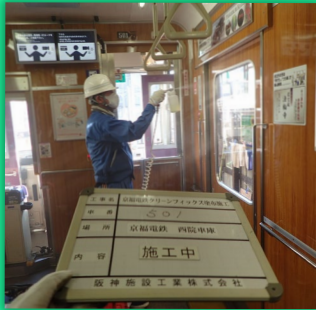
噴霧による施工
