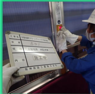
降車用押しボタン 施工中
