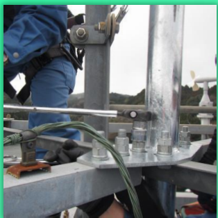
極性反転型避雷針 設置中
