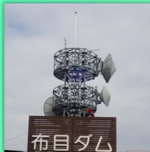
極性反転型避雷針 設置完了
