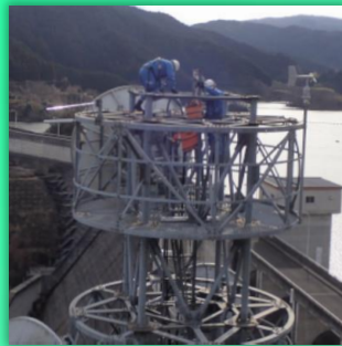
既設避雷針撤去
