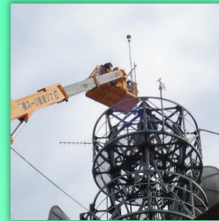
極性反転型避雷針 設置中
